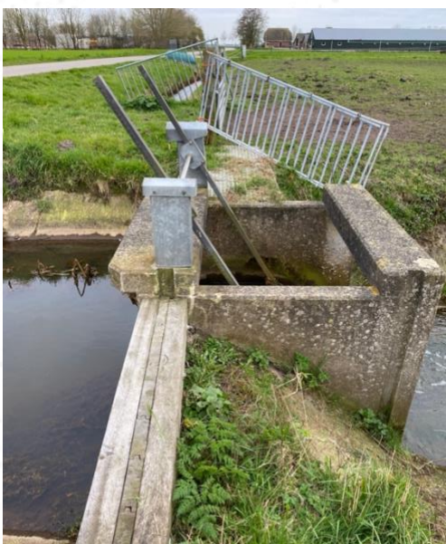
Figuur 2 Inspectie van kunstwerken
